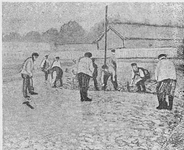
Рис. 5. Замощение булыжной мостовой
